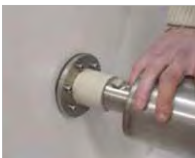
Opwikkelbuis draaien tot de inlegspie kan geplaatst worden.
