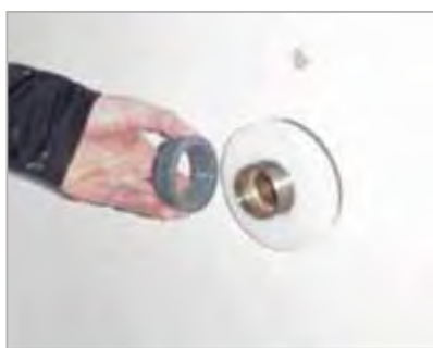
Plaatsen contramoer (handvast).
