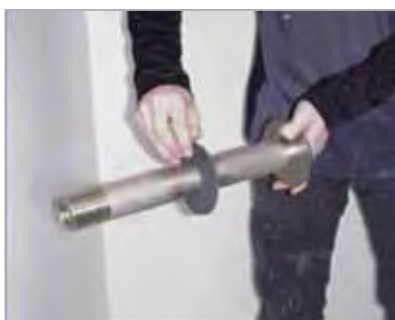
Pakking aanbrengen.
