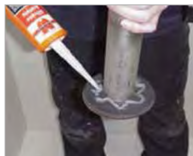
Kit op pakking aanbrengen.
