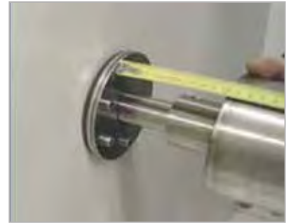
Lengte afstandsbus bepalen en op lengte maken.
